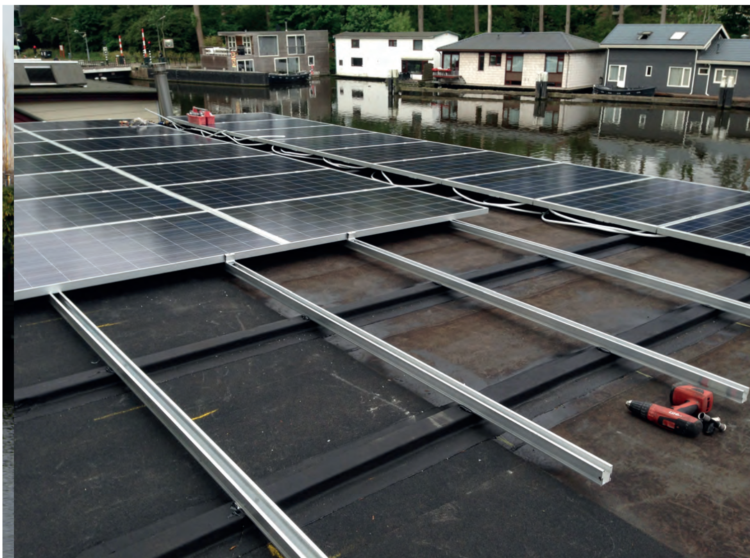
Tijdens de plaatsing van de panelen – platliggend is eenvoudig! (foto Andrea van de Graaf)
