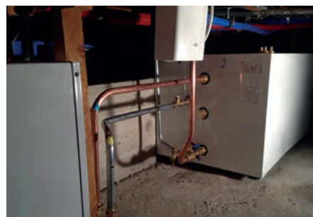
Twee warm water tanks omdat een grotere niet door het luik heen kon! (foto Andrea van de Graaf)
