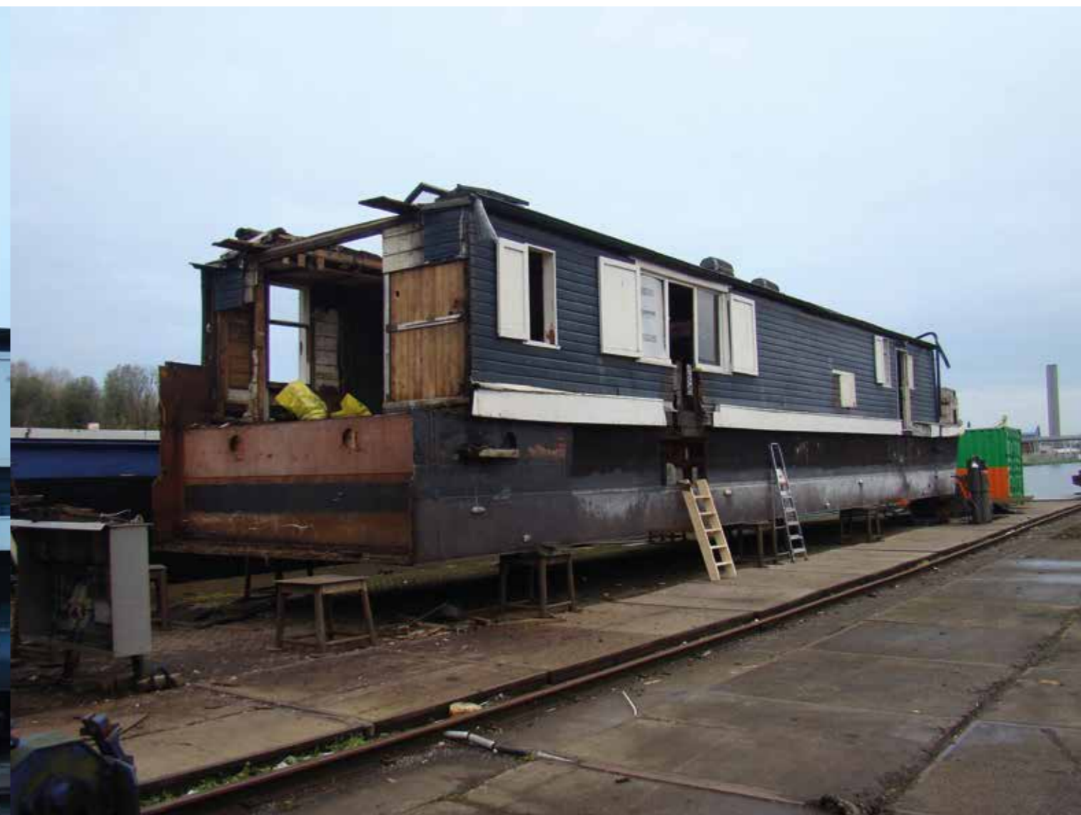
Het oorspronkelijke casco van het schip komt tevoorschijn. Dit was een rechthoekige bak waaraan later een losse kop en kont waren gezet.
